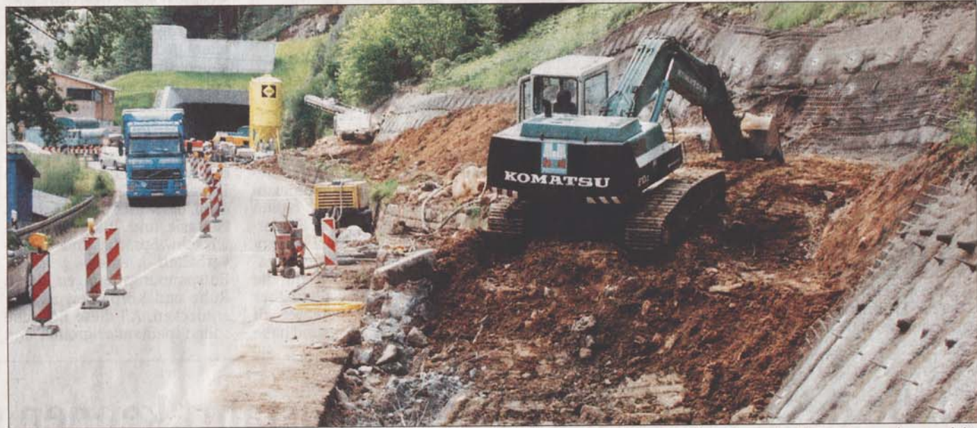
Am Nordportal des Tunnels wird derzeit für die Abbiegespur nach Hornberg Platz geschaffen. Dafür müssen der Hang abgegraben und die Böschung gesichert werden. Foto: Heinzmann
