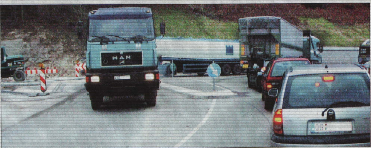
Zweispurig rollt der Verkehr seit Mitte der Woche auf der Umfahrung der Tunnelbaustelle. Vor allem für Einheimische ist die Verkehrsinsel noch etwas gewöhnungsbedürftig. Foto: Heinzmann
