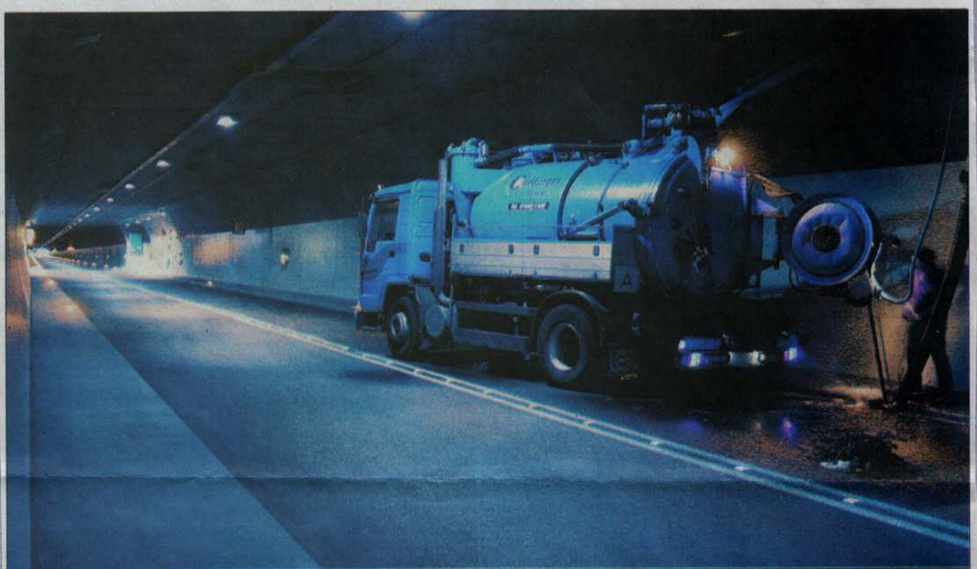
Arbeitseinsatz in der Hornberger Röhre: Die Drainagen und Entwässerungsleitungen werden mit einem Spezialfahrzeug durchgespült. In wenigen Monaten hat sich hier schon einiges angesammelt. Fotos: Heinzmann
