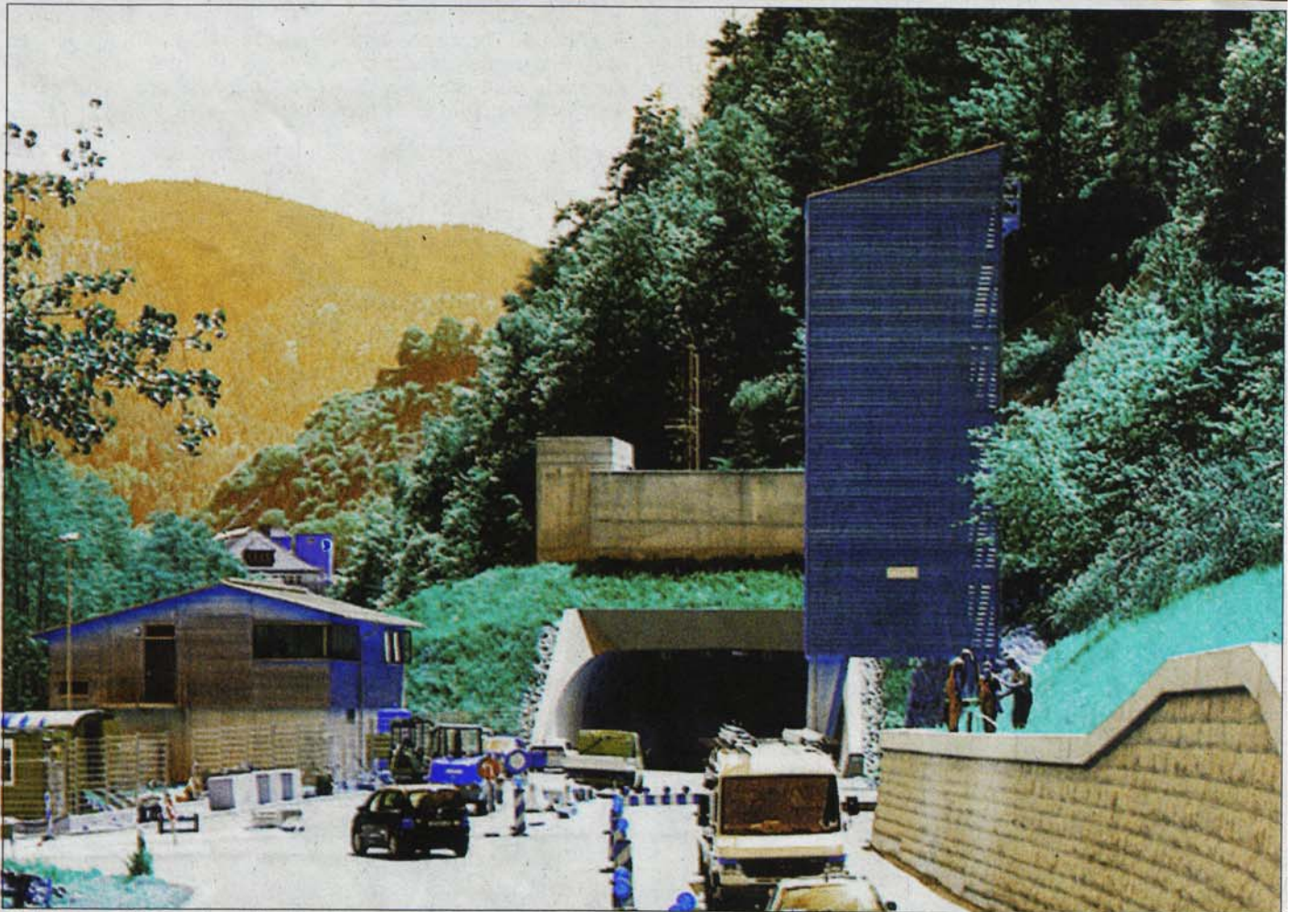
Nach langem Warten kann der Hornberger Tunnel ab 3. Juli befahren werden.
