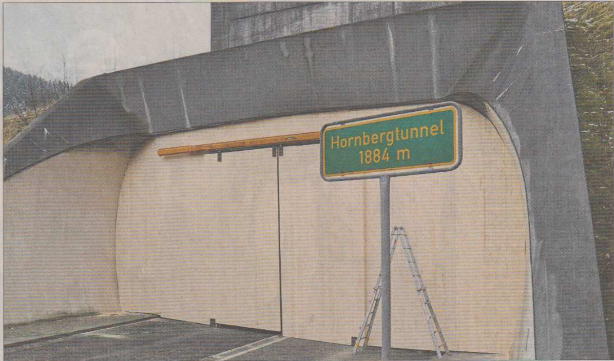
Noch ist der Hornbergtunnel für Bauarbeiten gesperrt. Wie Bürgermeister Siegfried Scheffold unserer Zeitung auf Nachfrage berichtete, werde die Sanierung wohl früher abgeschlossen als geplant. Fotos: Braun
